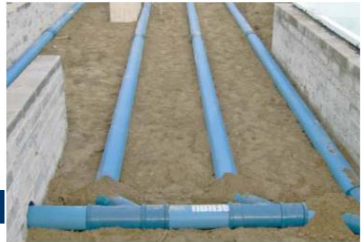
Uloženie rúr zemného výmenníka
